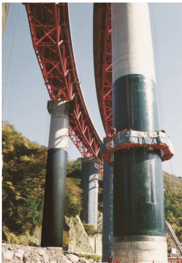
図表 11 コンクリート補強
